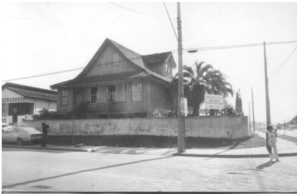
FIGURA 3 - SITUAÇÃO DA CASA EM 1984 – ANTES DO TRASLADO
