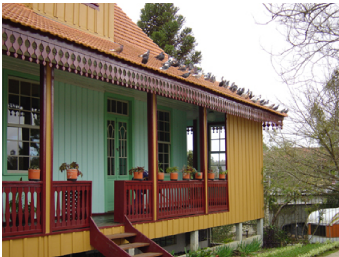
FIGURA 4 - SITUAÇÃO ATUAL DA CASA – FOTO EXTRAÍDA EM 2004
